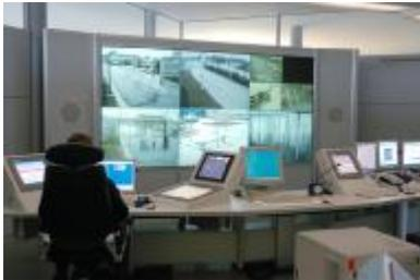
Technik. Ein wesentlicher Teil des Konzeptes war die Videotechnik: die ca. 90 installierten Kameras in den drei Werken in Friedrichshafen waren bislang mit konventioneller Technik angeschlossen und wurden auf Einzelmonitoren überwacht. Als wesentliche Eckpunkte für die Neuimplementierung der Videotechnik sind zu nennen:
